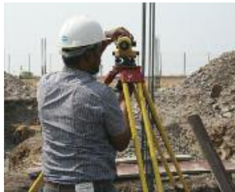
Site surveyor double-checking the dig site
